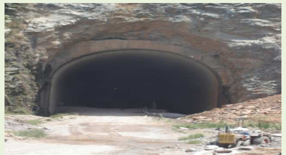
గండికోట రిజర్వాయరు వద్ద సొరంగం పని కొనసాగుతున్న దృశ్యం
