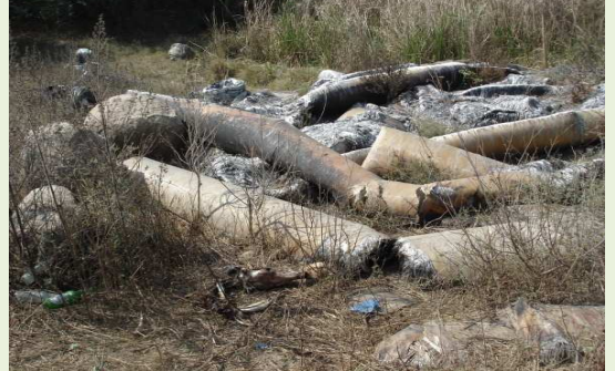
పార్ట్-IB పనులకు సంబంధించి నిర్మాణ స్థలంవద్ద కాలిపోయిన జీఆర్పీ పైపులు
