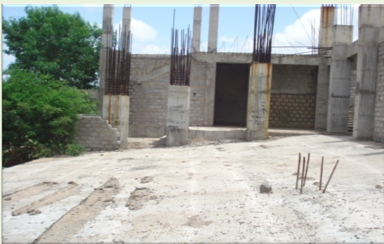
అనంతపురం జేఎన్టీయూ ఆడిటోరియంలో కూలగొట్టిన కాంక్రీటు శాబులు, స్ట్రెజ్ బీమ్ (2012 ఆగస్టు 10)
